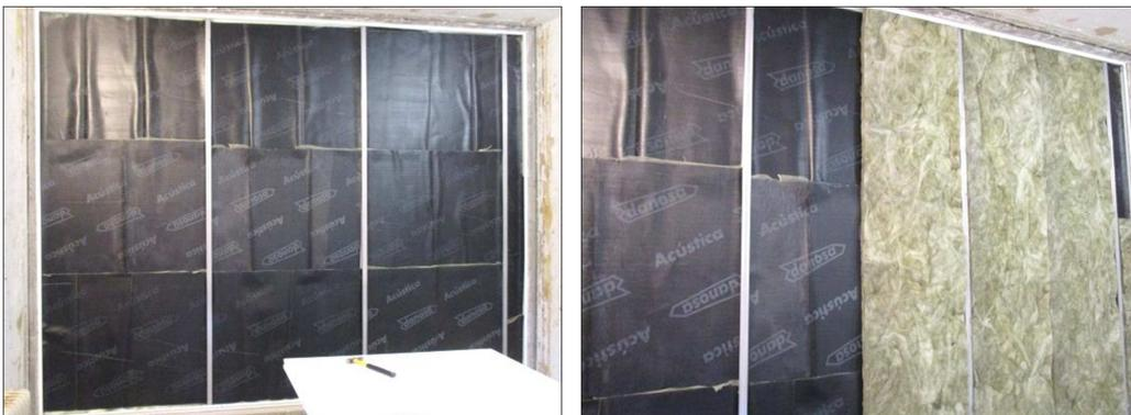
**Imágenes 12 y 13 Instalación de la lámina bituminosa y de la lana mineral**
